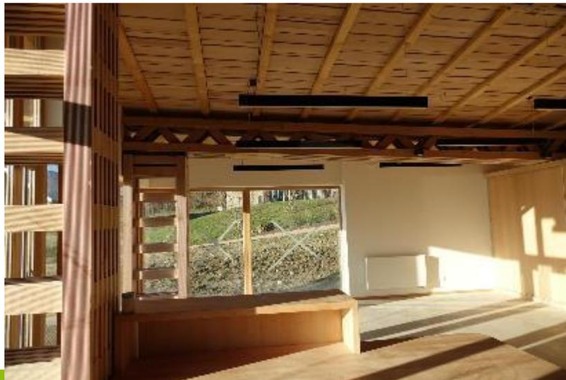
Poutre treillis et poteaux réalisés à partir d'assemblage par picots – Maison de vélo Xertigny (88) (Jean-Luc Gérard Architecte ©JLG)
