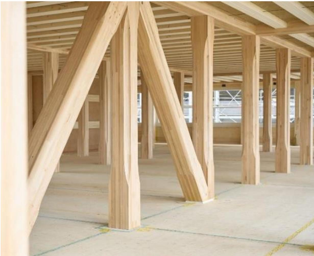
*Poteaux et poutres principales en hêtre, poutres secondaires en résineux et plancher en CLT résineux (SENN ©David Walter)*
