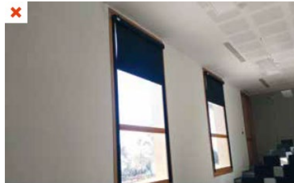
Rideaux roulants intérieurs de couleur noire qui n'empêchent pas les surchauffes d'un amphithéâtre exposé est. ©AQC
