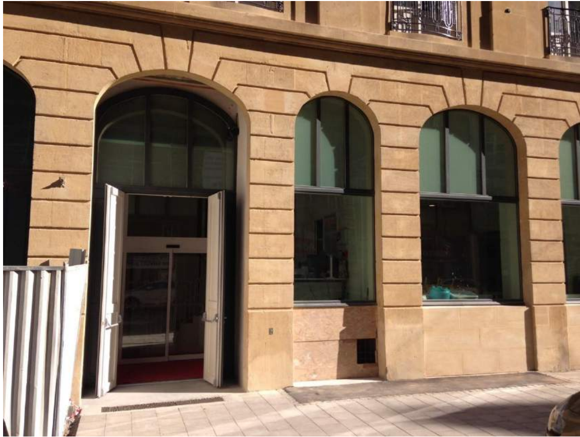
Construction de la crèche Charlemagne à Metz (57)
