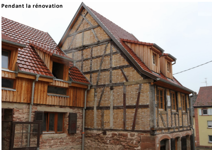
Pendant la rénovation
