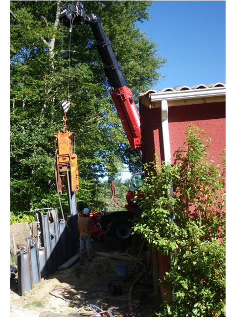
Ecran palplanches métalliques Maison rouge
