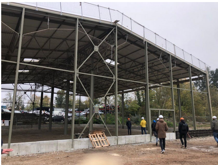
Photo prise lors de la visite construction d'un hangar logistique avec charpente réemployée et couverture photovoltaïque à Bouxwiller (67)
